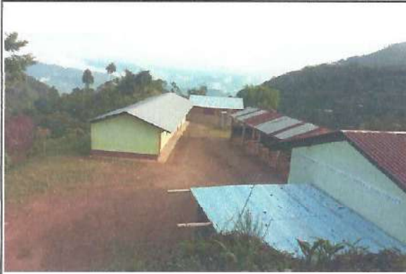
Foto 1: Mejoramiento de modulo tipo portico con lamina troquelada calibre 26
