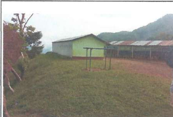
Foto 2: Mejoramiento de modulo tipo portico con lamina troquelada calibre 26
